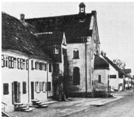
Abb. 7: Synagoge von Fellheim 19
